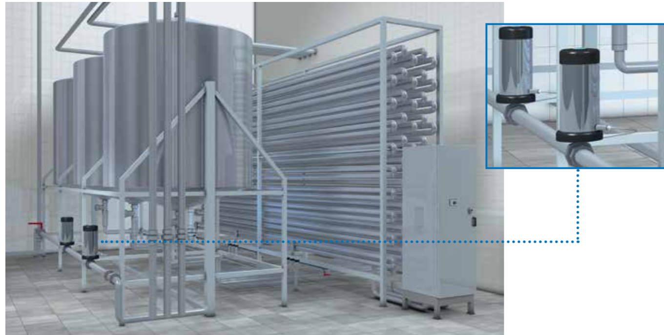
Überwachung der Stellung der Ventile von Mischern oder Heizanlagen
